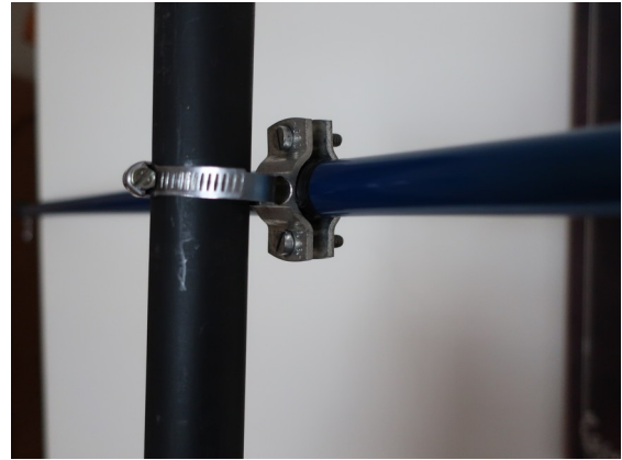
Bild 4: Der Horizontalausleger wurde für einen ersten Versuch mit einer ehemaligen Erdbriede bewerkstelligt. Da ist ganz sicher später eine Optimierung möglich!
