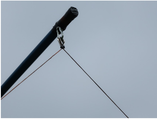
Bild 3: Horizontalausleger für Strahler und Reflektor. Hier kann die Öse der Loopspitze eingehängt werden. Für nur einen Loop gibt es eine Aufhängemöglichkeit direkt am Mast-Top.
