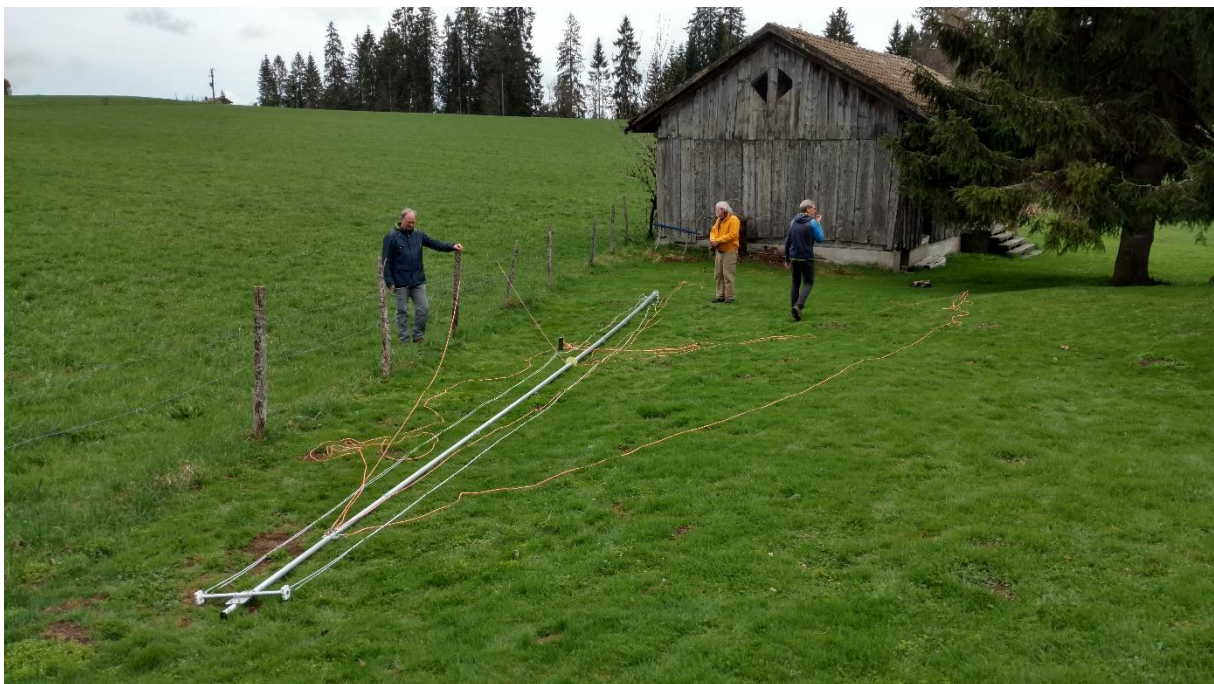
Bild 1, Aufbau des 12m Aluminiummastens
