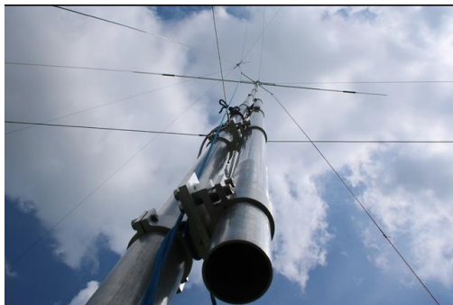
Alle Antennen konnten bei gutem Wetter aufgestellt werden. Hier ein Blick von unten auf die Antenne für die höheren Bänder
